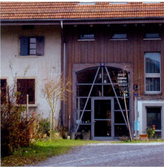
Oberdorfstrasse 13 in Illnau: Synthese von Alt und Neu am Beispiel des ehemaligen Tenntors.
