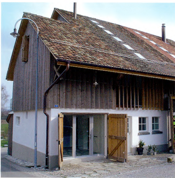
Oberholzstrasse 2 in Moosburg-Effretikon: Stall und Scheune vor und nach dem Umbau.
