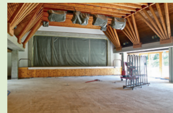
Der Lockout bietet eine gute Gelegenheit, die geplanten umfassenden Renovationsarbeiten im Rösslisaal etwas vorzuziehen.
