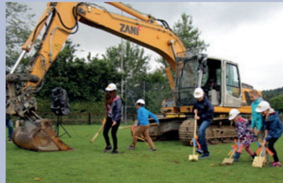
Kinderarbeit für einmal begehrt: Baubeginn bei der Schulanlage Hagen.
