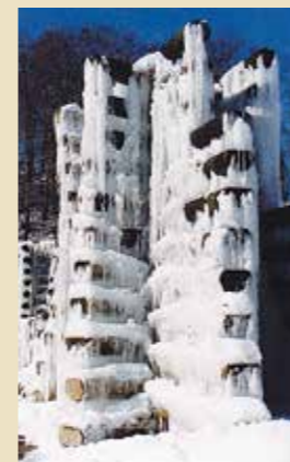
Die Holzskulptur «Rägestäge», ein beliebtes Winter-Fotosujet in der Kläranlage, muss aus Sicherheitsgründen abgebrochen werden.
