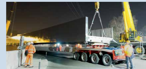
Mitten in der Nacht wird in Effretikon die Stahlbrücke über die Gleise gelegt.
